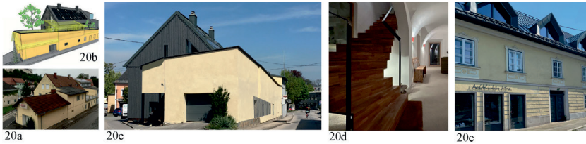
Abb. 20: Revitalisierung Rathausplatz 7 in Kremsmünster, Arch. Klasz 2023–2024, Privatarchiv Klasz | Abb. 20a: Das leerstehende Bestandgebäude vor der Revitalisierung, Foto 2022 | Abb. 20b: Der 3D-Ausführungsplan, 2023 | Abb. 20c: Das sanierte Gebäude von der Westseite fotografiert, 2024 | Abb. 20d: Der Gewölberaum des Foyers mit der neuen Stiege aus Stahl und Eichenholz, 2024 | Abb. 20e: Die Nordfassade des revitalisierten Gebäudes vom Rathausplatz aus fotografiert, 2024
