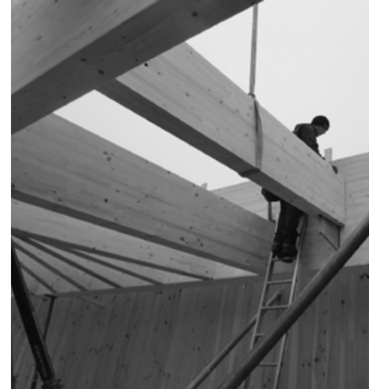
Die doppelt gekrümmte Dachkonstruktion wird aus geraden Brettschichtholzträgern als hyperbolisches Paraboloid effizient hergestellt.
