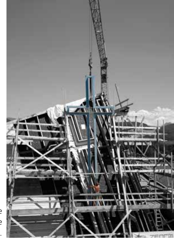
Die doppelt gekrümmte Dachkonstruktion wird aus geraden Brettschichtholzträgern als hyperbolisches Paraboloid effizient hergestellt.
